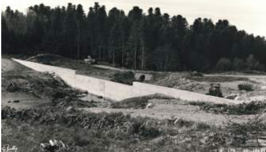
03-10-1968- Digue nord du Tact - Vue aval - archives d'EDF de Bort-les-Orgues
