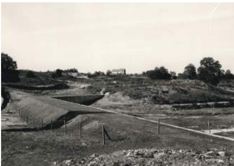
15-11-1968 - Digue sud du Tact - Vue amont - archives d'EDF de Bort-les-Orgues
