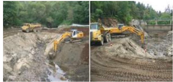
Opération de curage des sédiments en amont du barrage de Brumessanges
